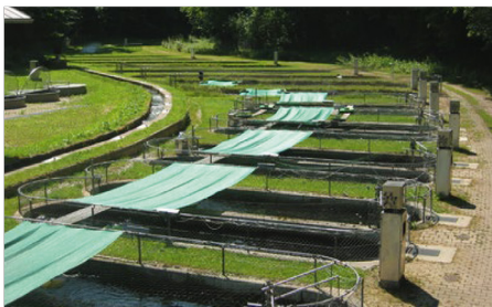
Becken einer Forellenzuchtanlage (Foto: LfL Starnberg)
