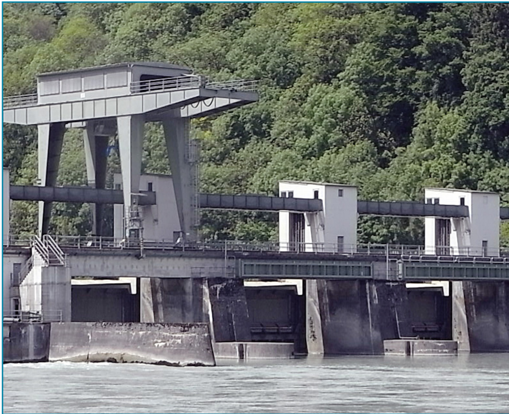
Typisches Wasserkraftwerk am Inn
