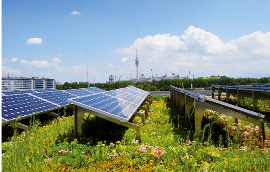
Abbildung 12 Kombination von Dachbegrünung und Photovoltaikanlage auf dem Münchner Technologiezentrum (Foto: ZinCo GmbH).
