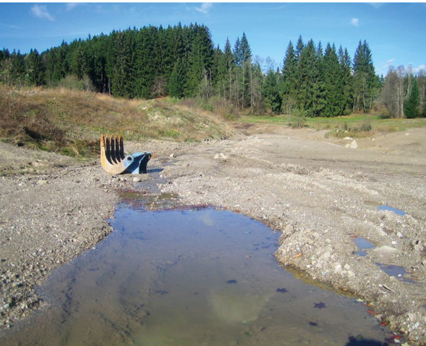
Abbildung 14 Erdarbeiten für eine Ausgleichsfläche (Foto: ifuplan).
