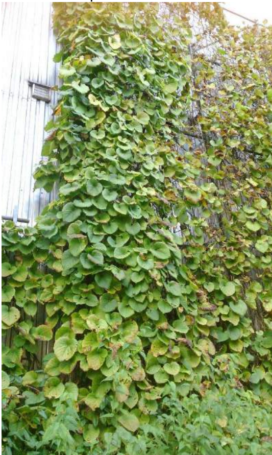
Abbildung 18 Fassadenbegrünung Rosenheim (Bildquelle: ifuplan)
