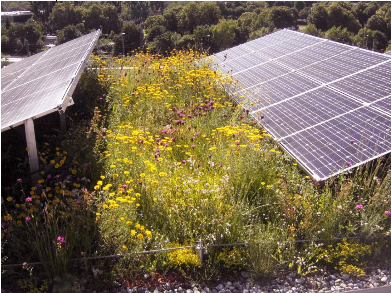
Abbildung 16 Extensive Dachbegrünung Landratsamt Tübingen (Bildquelle: Dachbegrünung Landratsamt Tübingen geplant durch Landschaftsarchitekten BDLA Stötzer und Nehrer, Sindelfingen)
