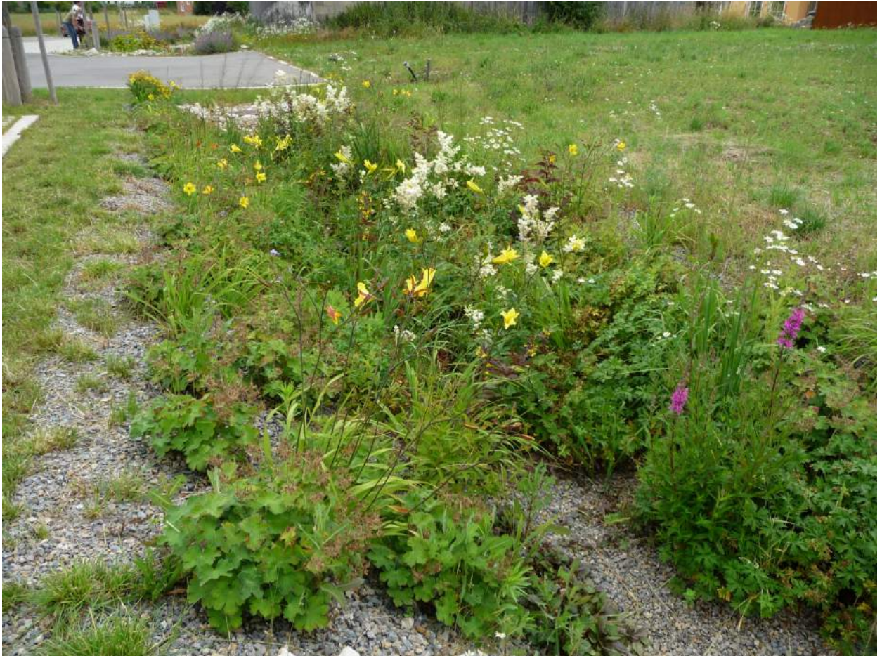
Abbildung 15 Entwässerungsmulde mit standortgerechtem Bewuchs (Bildquelle: LWG, A. Eppel-Hotz)
