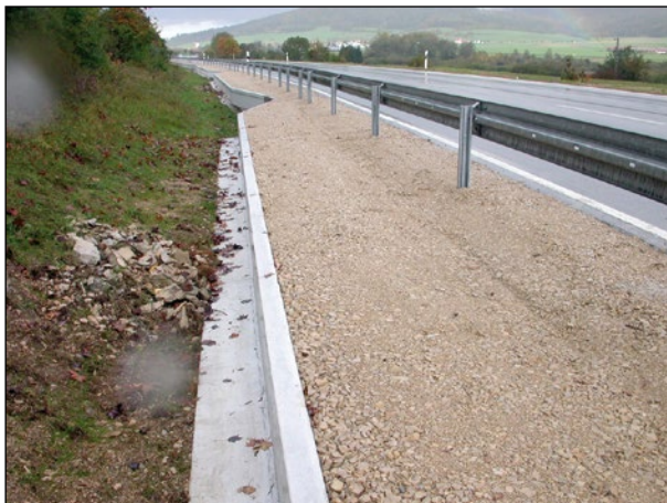
Abb. 7: Fest installierter Amphibienschutzzaun und stationäre Durchlassanlage
