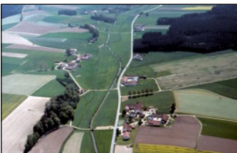
Abb. 34: Naturfernes, ausgebautes Gewässer: Hohes Konfliktpotenzial
